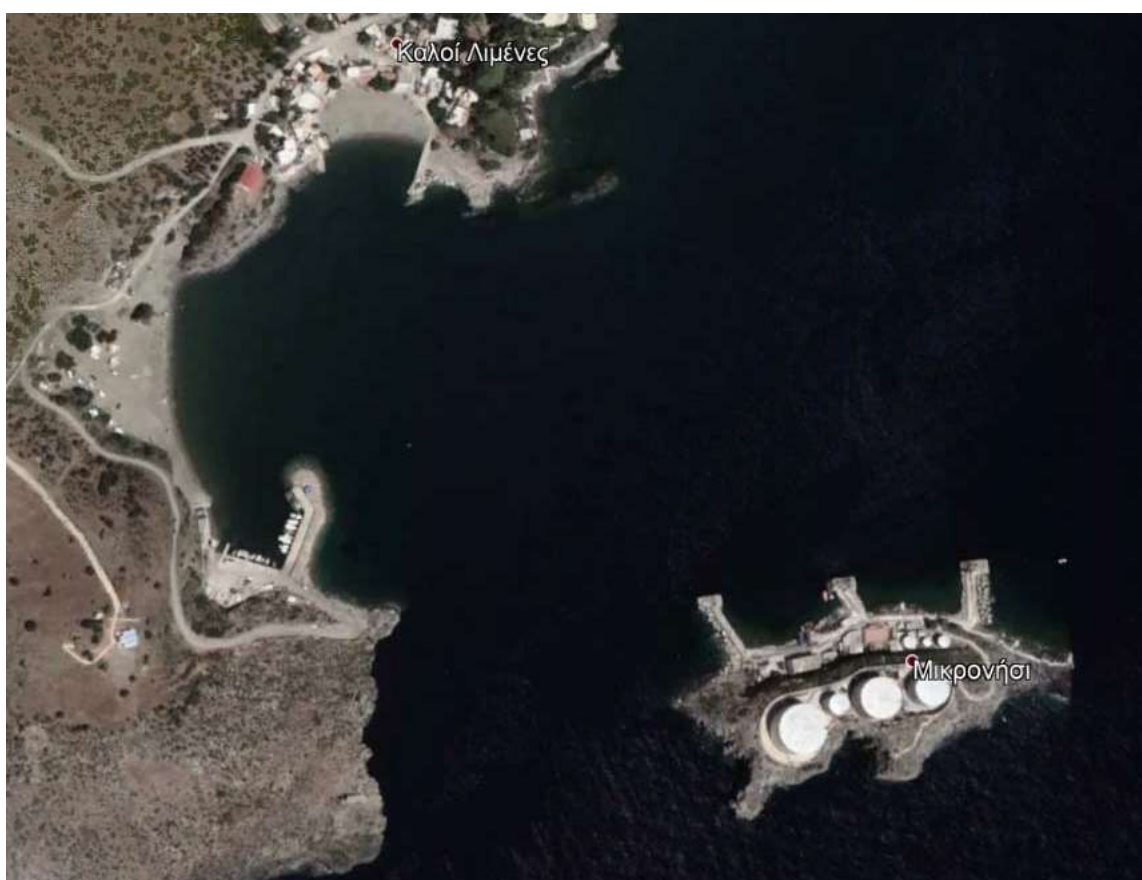
Εικόνα 7-71 Σταθμός ανεφοδιασμού πλοίων με ναυτιλιακά καύσιμα, στη νησίδα Αγ. Παύλος (Μικρονήσι).
